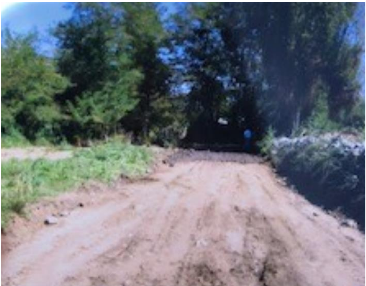
En esta foto se aprecia la plataforma con señas de paso de maquinaria y colocación de material granular.
